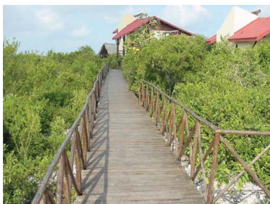
Figura 42. Obras ligeras para la prestación de servicios en la zona costera. Punta Periquito, Cayo Las Brujas. Fotógrafo: José Manuel Guzmán Menéndez, Instituto de Ecología y Sistemática
